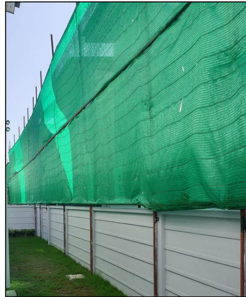
รูปที่ 4.1.4-1 ตัวอย่างรั้วชั่วคราว (Aluminum Sheet) และต่อด้วยตาข่าย/ผ้าใบ
