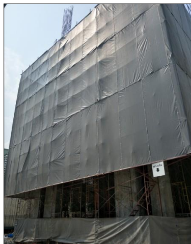
รูปที่ 4.1.4-1 ตัวอย่างรั้วชั่วคราว (Aluminum Sheet) และต่อด้วยตาข่าย/ผ้าใบ
