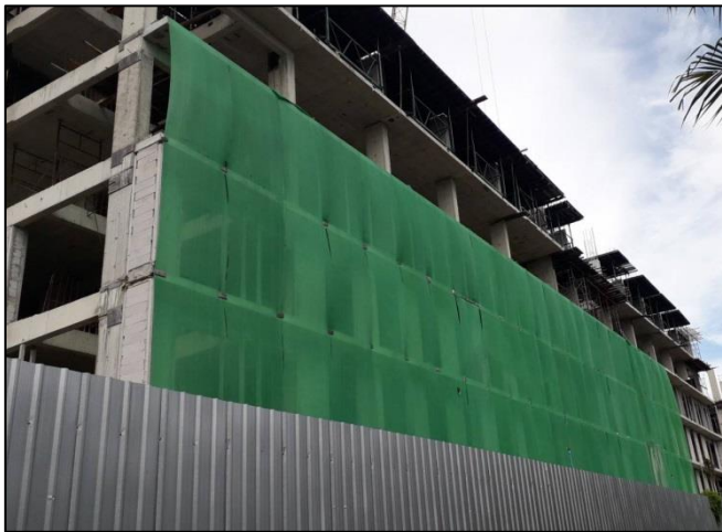
รูปที่ 4.1.4-1 ตัวอย่างรั้วชั่วคราว (Aluminum Sheet) และต่อด้วยตาข่าย/ผ้าใบ
